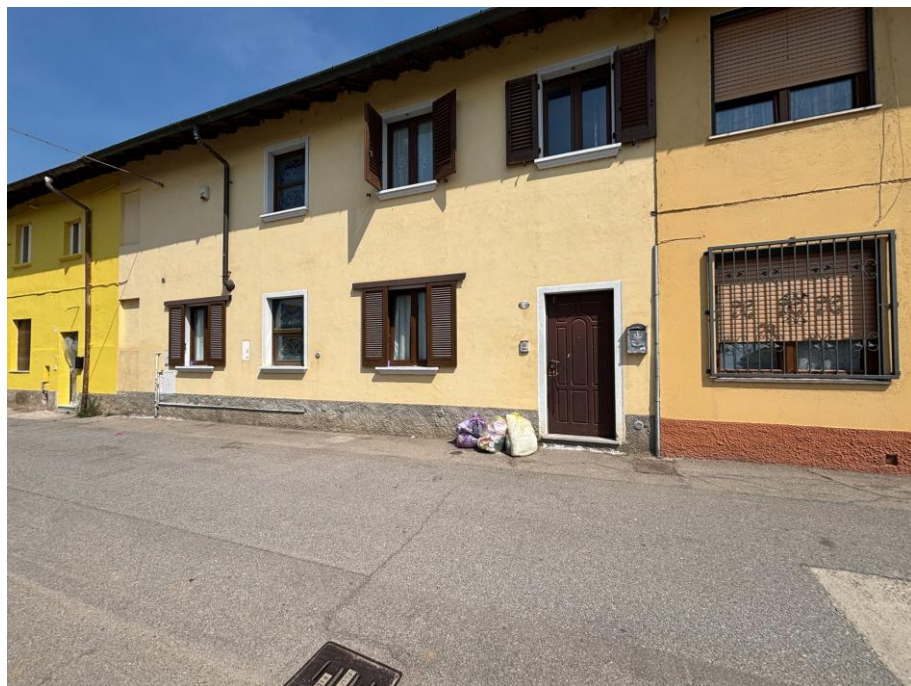
Immagine 1. Vista dalla strada della cortina edilizia. L'unità oggetto di valutazione è quella con la facciata tinteggiata nel colore giallo chiaro.
